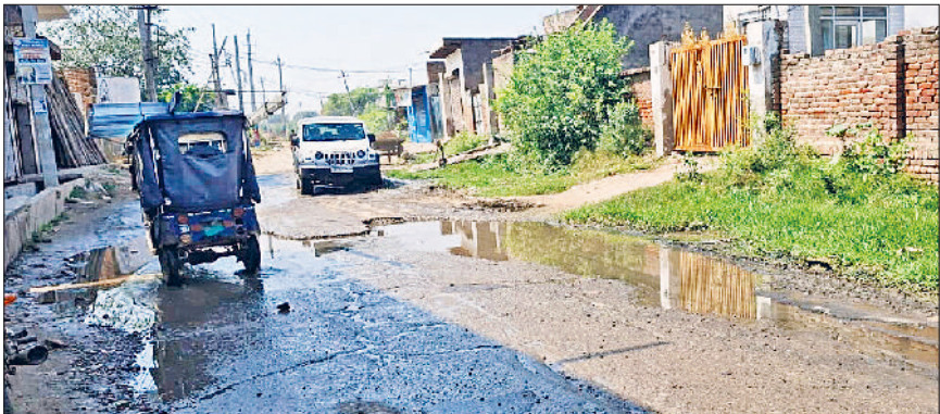
झज्जर। रहनिया कॉलोनी में जलभराव से निकलते वाहन।
